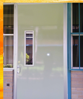
Colocación de puertas nuevas en los laboratorios curriculares
