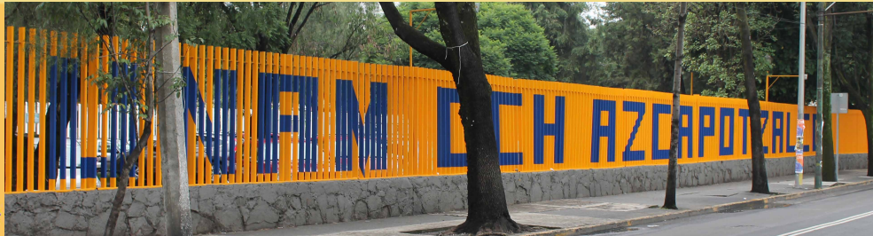
Colocación de pintura en reja tipo UNAM
