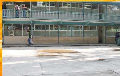
Cambio de piso enfrente de los edificios "C", "D" y "E"
